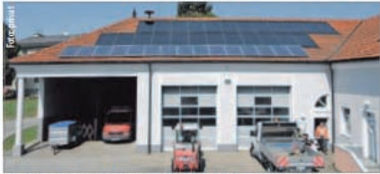
Photovoltaik- und Solaranlage auf dem Dach des Bauhofes Utzenaich.
