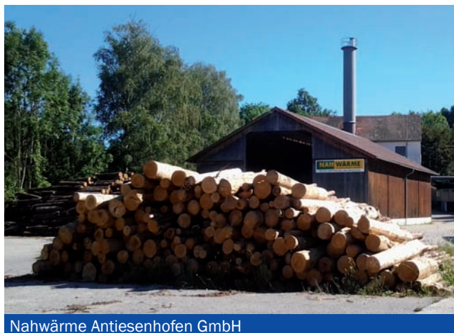
Nahwärme Antiesenhofen GmbH
