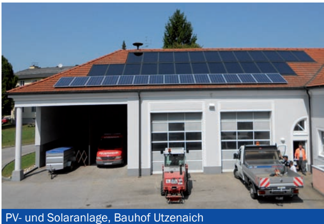
PV- und Solaranlage, Bauhof Utzenaich
