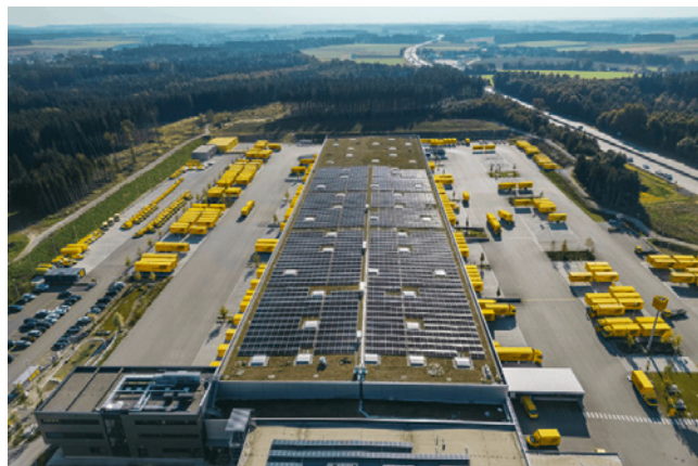
©Österreichische Post AG – Dachbegrünung
